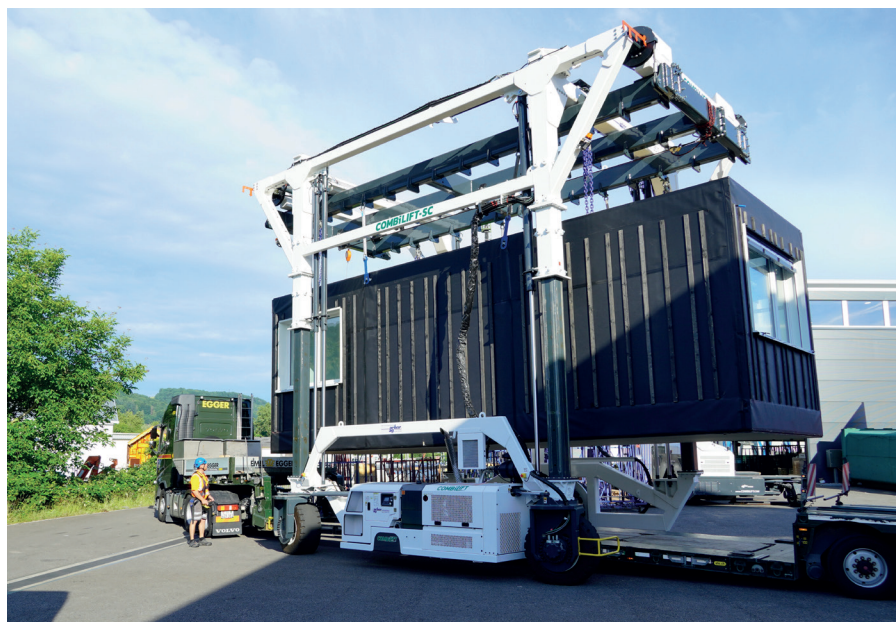
Fertiges Container-Modul wird mit dem Straddle Carrier auf den Tieflader aufgeladen.
