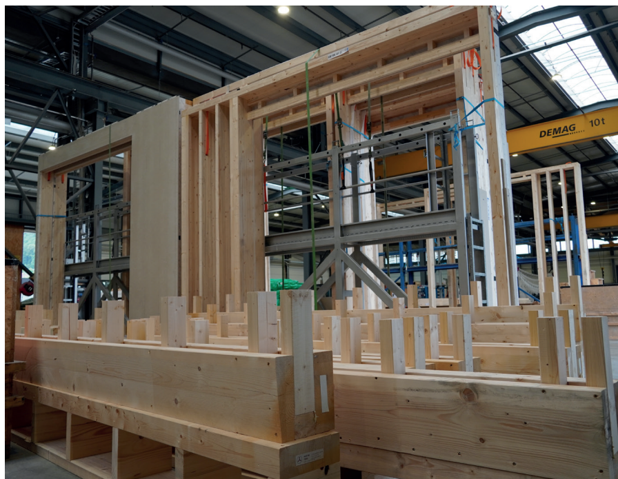
Herstellung von Baugruppen für das Container-Modul.
